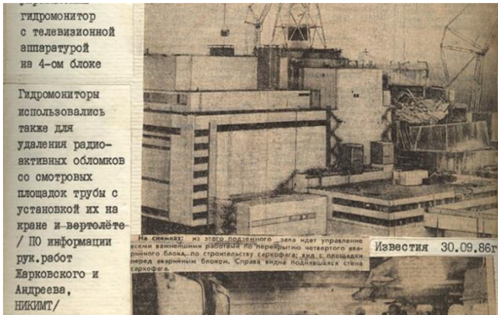
Рисунок 10. Работы по перекрытию четвертого аварийного блока на Чернобыльской АЭС
