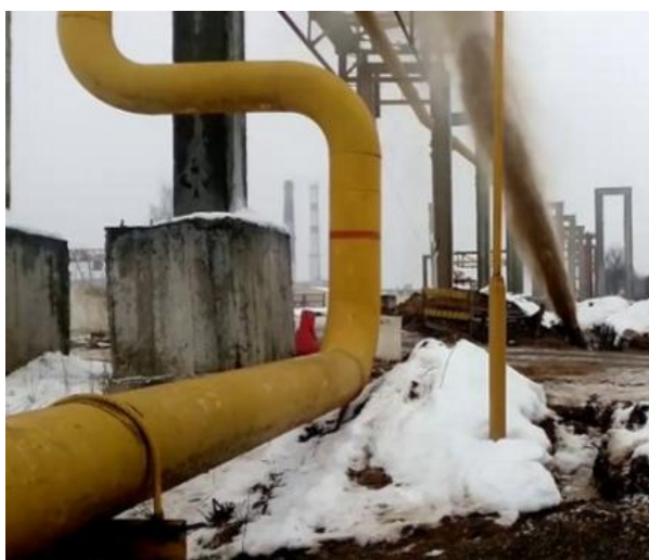
Рисунок 9 - Промывка магистральных труб
