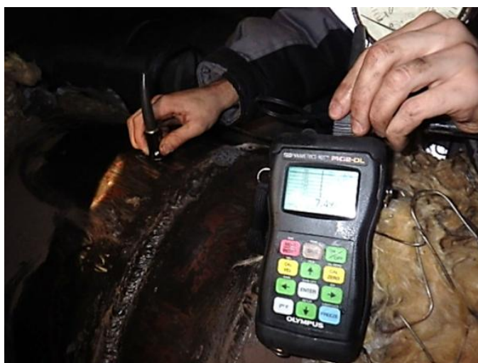
Рисунок 5 - Измерение толщины стенки трубопровода ручным способом
