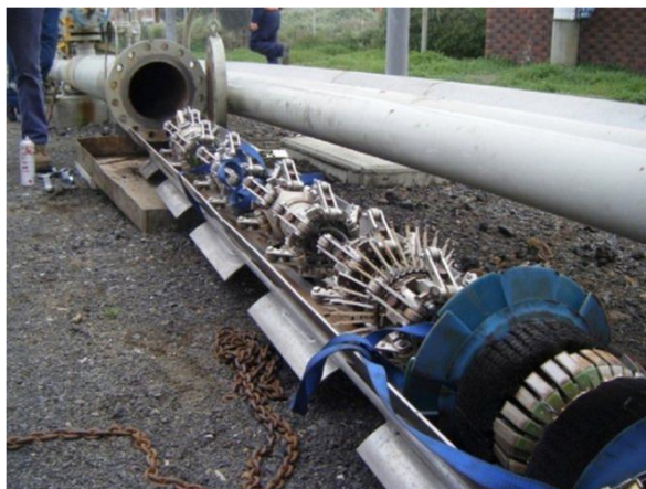
Рисунок 8- Прочистка газовых линий поршнем
