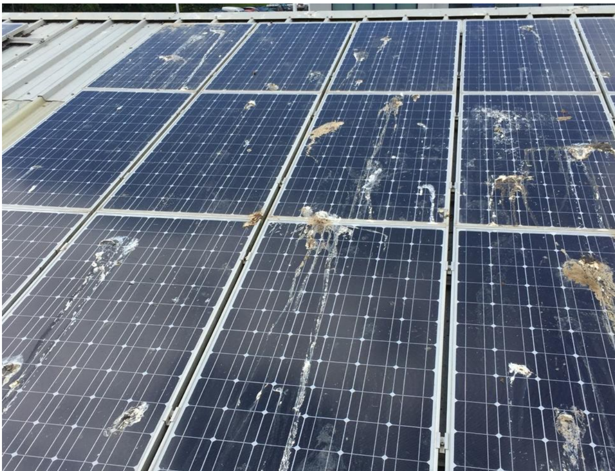
Рисунок 5. Загрязнение панелей птицами.
