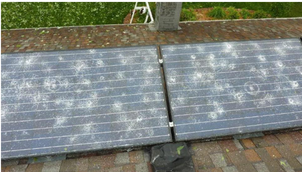
Рисунок 7. Повреждение панелей градом. Канберра 2020 год.
