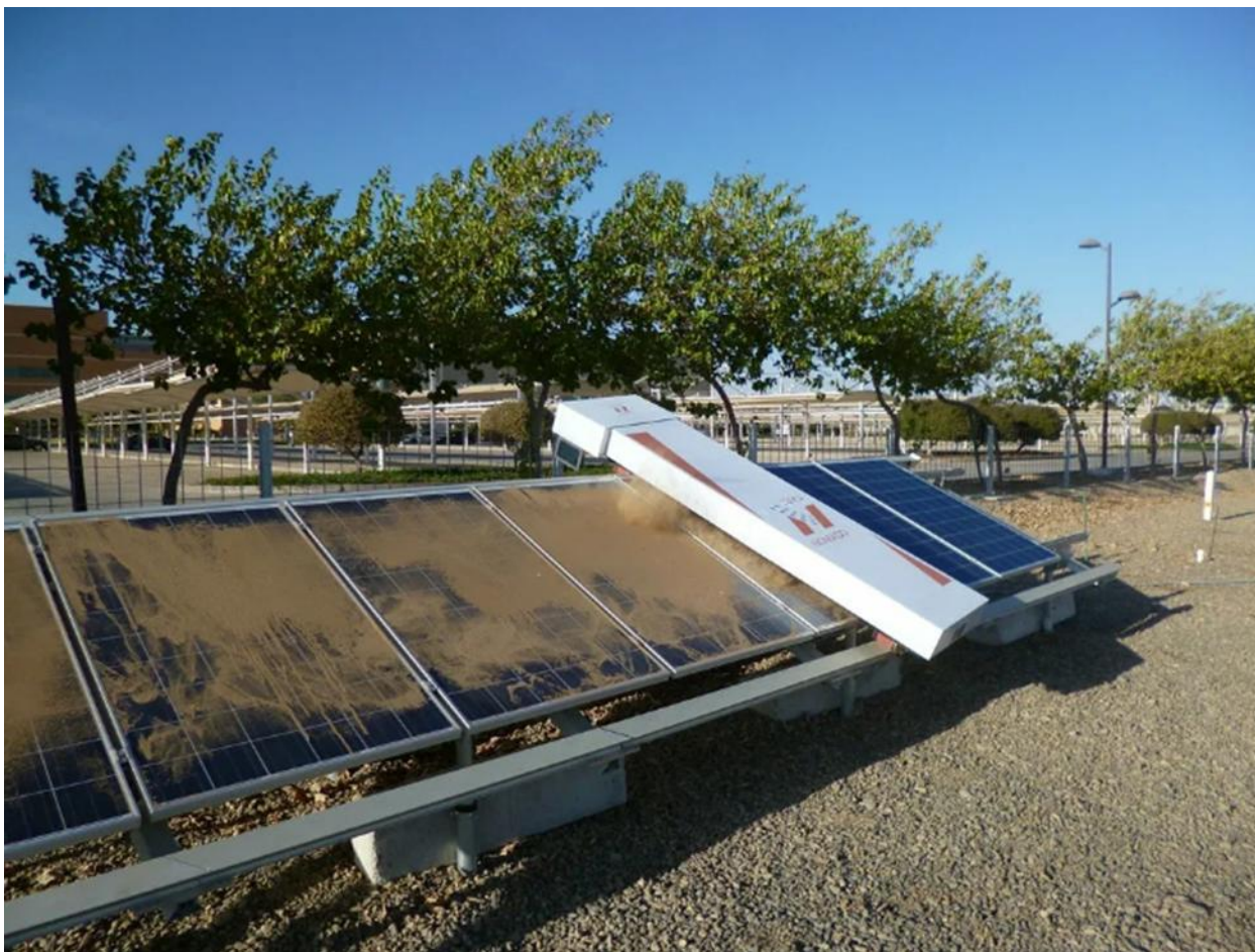
Рисунок 3. Загрязнение песком после бури.
